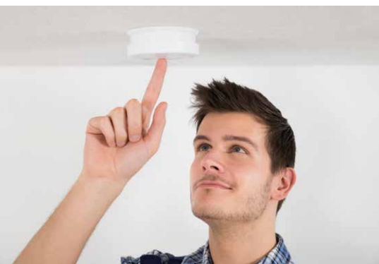
Jährliche Funktionsprüfung des Rauchwarnmelders
