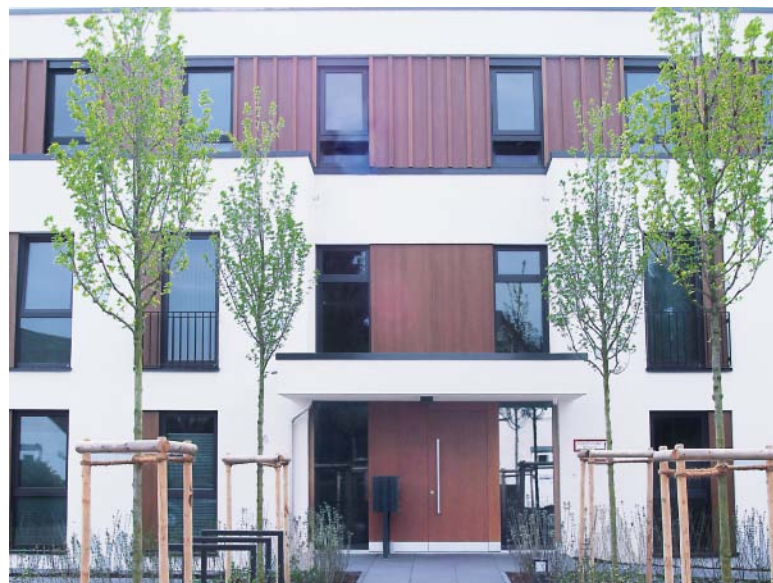
Nachverdichtung Korekamp, Neubaumaßnahme Haverkamp
