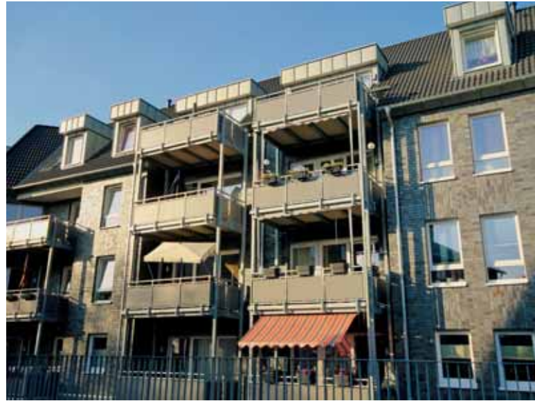
Neubaumaßnahme Traarer Straße
