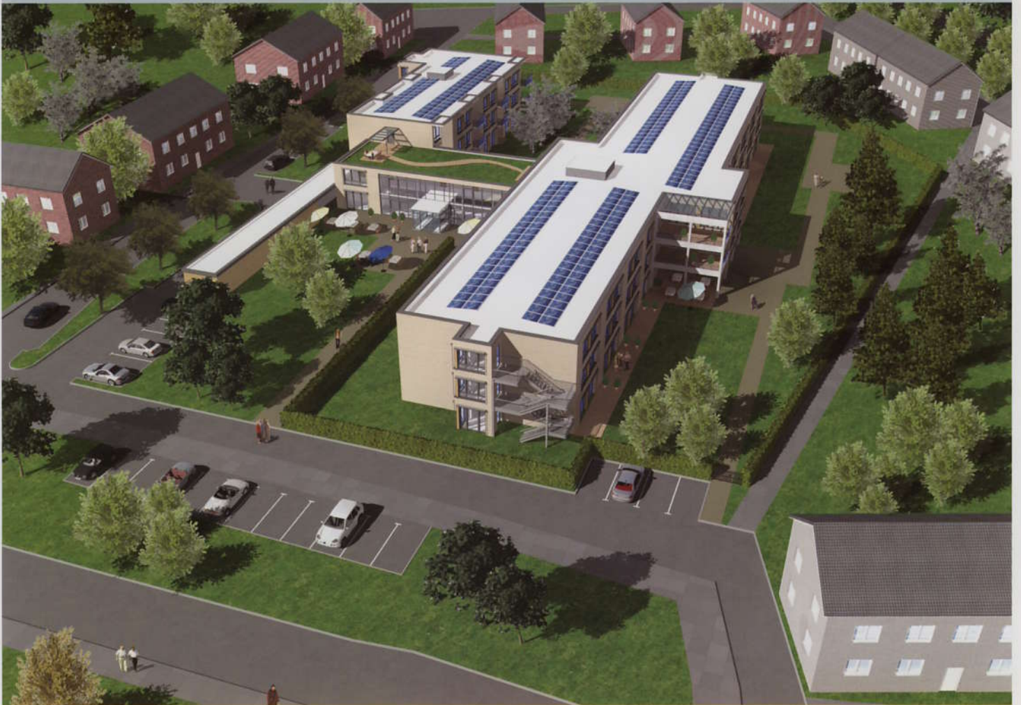
Neubaumaßnahme Seniorenheim Krefeld-Linn
