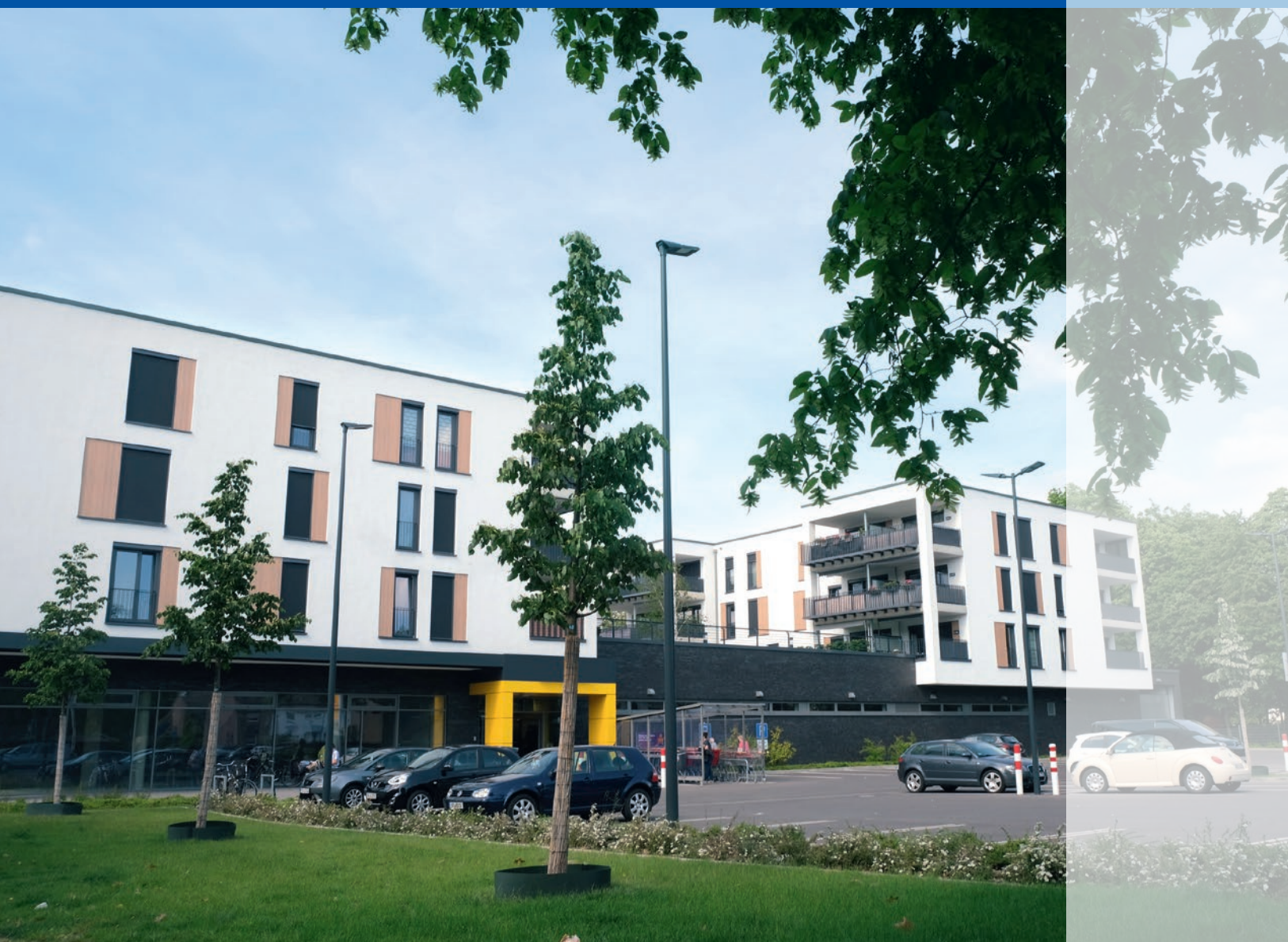
Neubaumaßnahme Breslauer Straße
